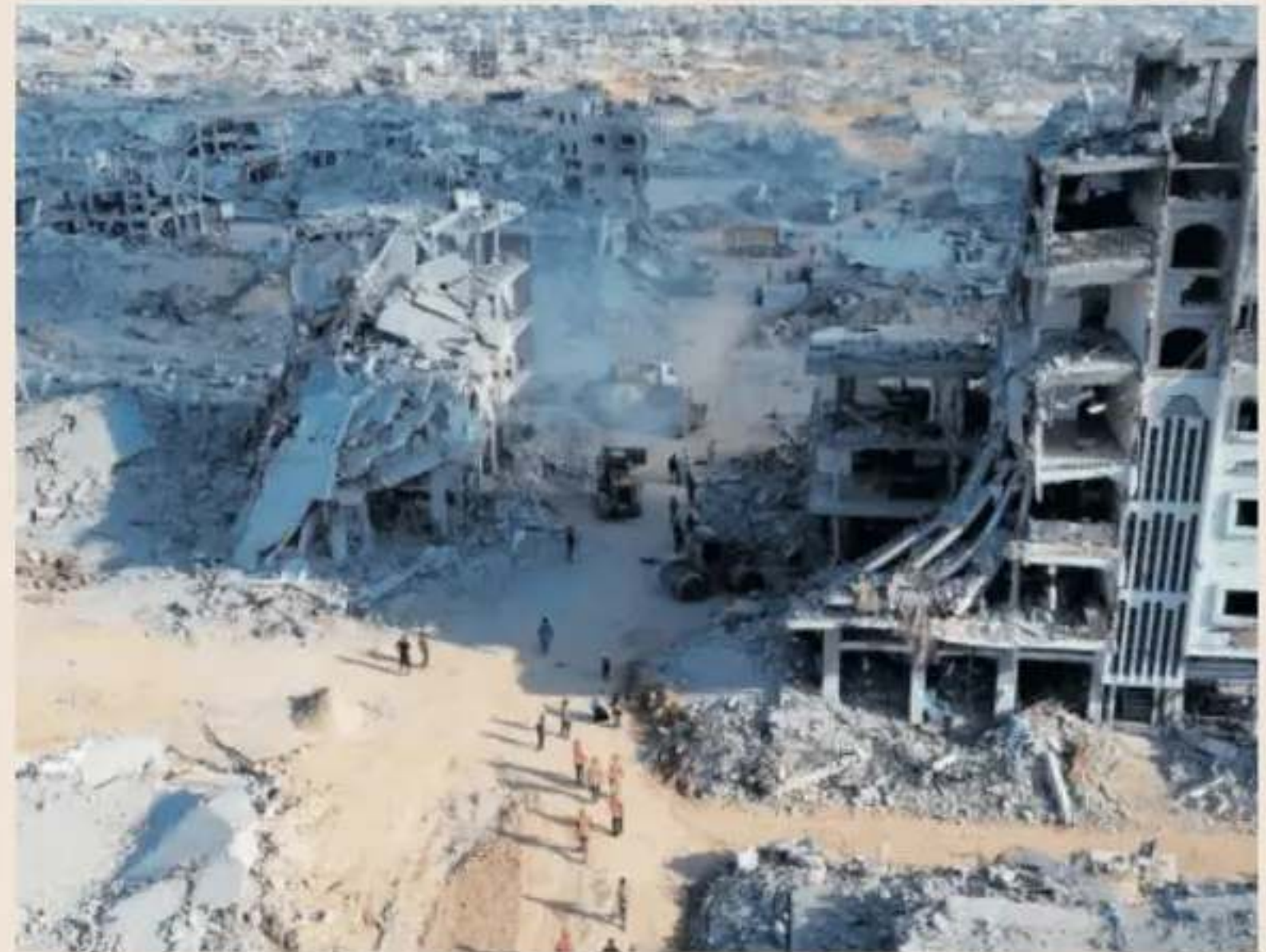
Varios trabajadores retiran restos de edificios destruidos durante la guerra, ayer, en Jan Yunis. GETTY IMAGES
