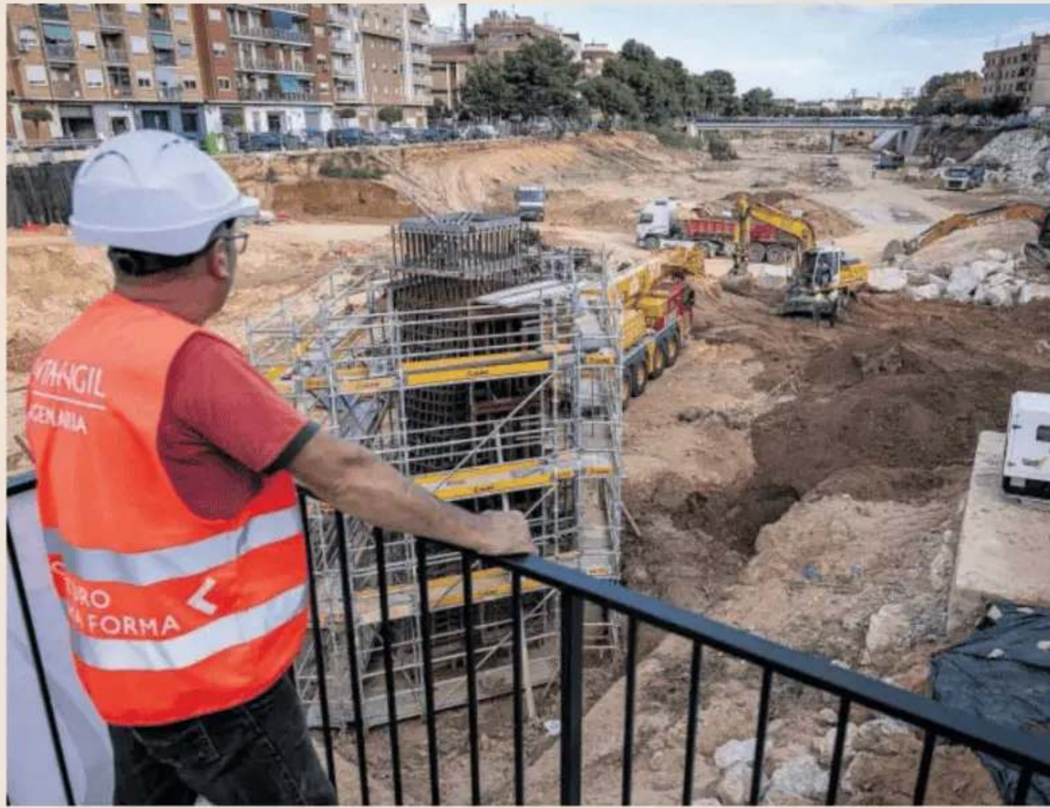
Cauce del barranco del Poyo, en Paiporta, donde el pasado 22 de octubre seguían trabajando decenas de obreros con maquinaria pesada en obras impulsadas por el Estado y la Confederación del Júcar. MÓNICA TORRES
