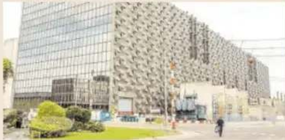
Sala de turbinas de la central de Almaraz. ÁLEX ONCIU
